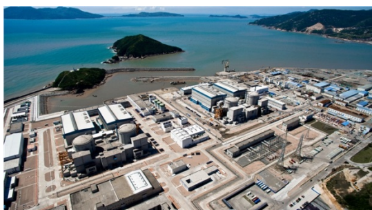
寧徳原子力発電所
