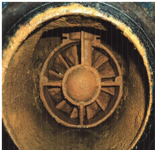
マンガン等が付着して層を成している 西ネグロス州バコロド水道局管内における水道管内部（西ネグロス州バコロド市水道局提供） 水道管の建設年（築年数）とその長さ
